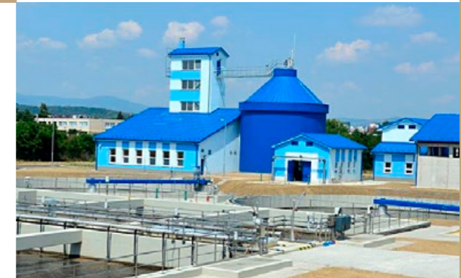
WTP, Nové Mesto nad Váhom, Slovakia
